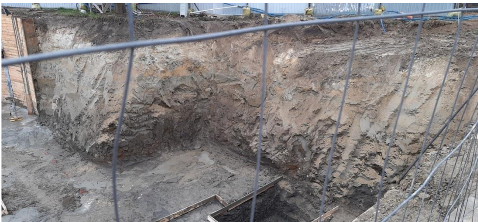
Ryc. 9. Wykop pod nową inwestycją w pobliżu ulicy Stryjeńskich, kilkadziesiąt metrów na północny zachód od marketu Lidla (grudzień 2020).
